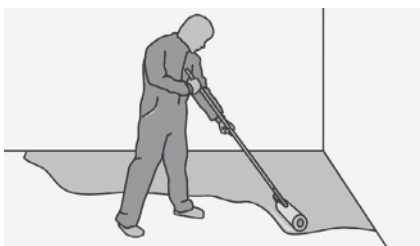
Рис. 20. Грунтование стяжки
